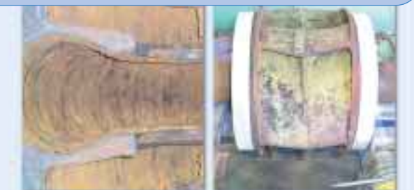
Yläkupu ja pronssinen juoksupyörä ennen korjausta. Ensimmäinen vaihe on raepuhalltaa osat SA-3puhtausasteeseen ja 75 µm profiiliin.
